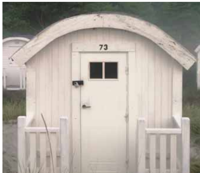
Badhytt 73 under renovering hösten 2007.
